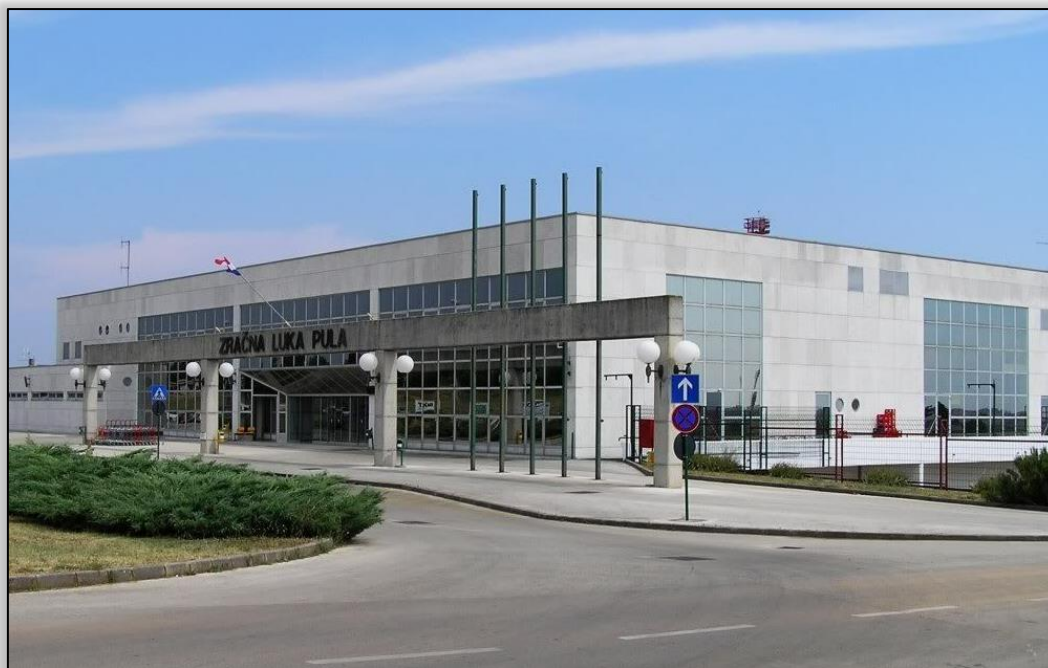
Slika 2. Zgrada Zračne luke (izvor: internet)
